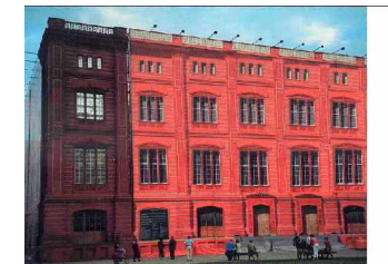
Schaufassade mit integrierter Musterfassade
