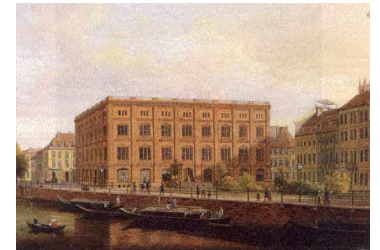
C. D. Freydanck: Ansicht der Kgl. Bauakademie
